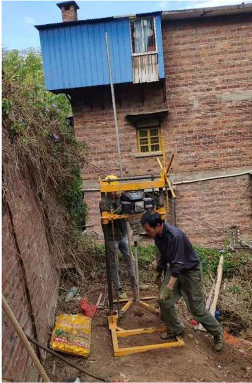
图 10: 钻机安装
