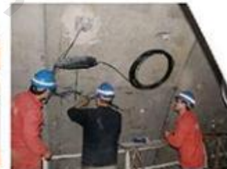
隧道内部铺设光缆
