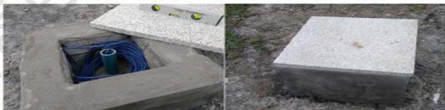
深部位移-安装光纤光栅测斜管
