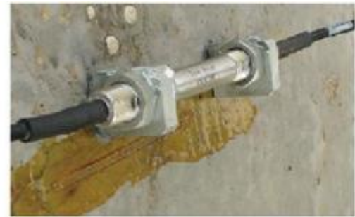
安装在混凝土轨道板上的应变计
