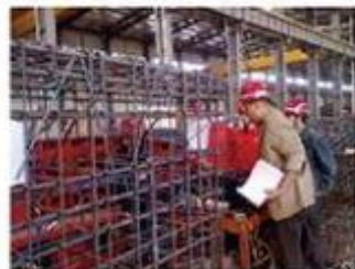
(管片厂)传感器 固定在钢筋笼上
